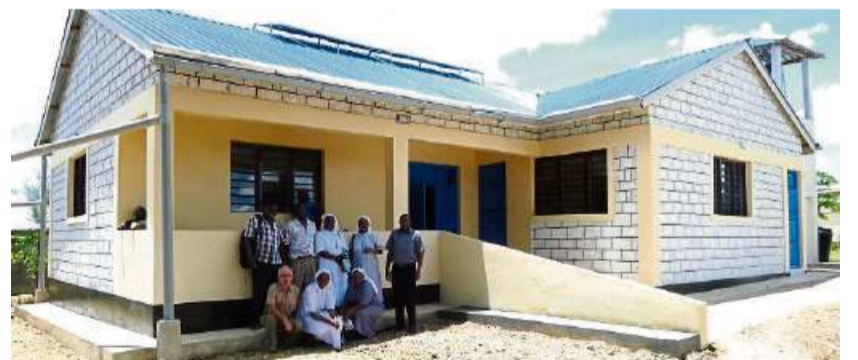
Das Geburtshaus ist fertig.
