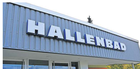
Der Landesrechnungshof hat auch das Gelnhäuser Hallenbad unter die Lupe genommen – das Ergebnis sorgt für Aufregung im Zweckverband. FOTO: ARCHIV
