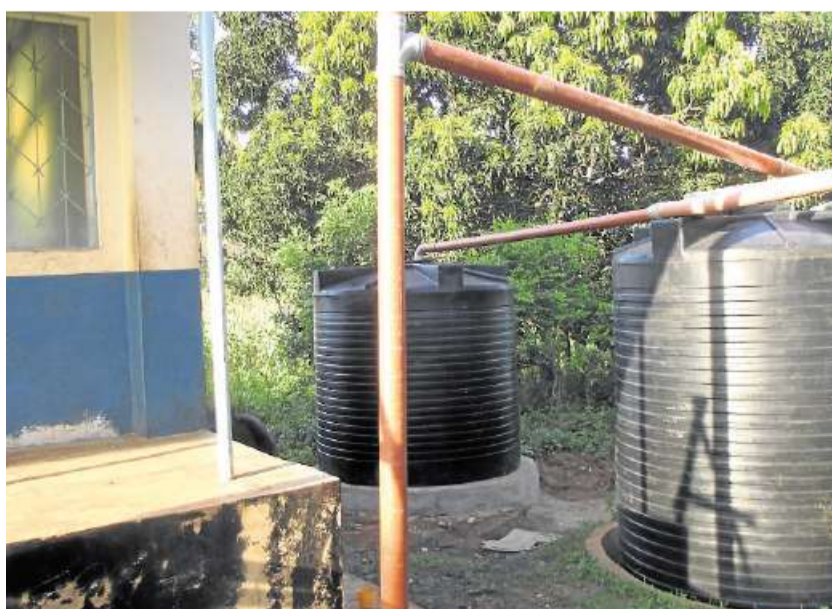
Mit Hilfe aus Höchst konnten weitere Wasserbehälter fertiggestellt werden.
